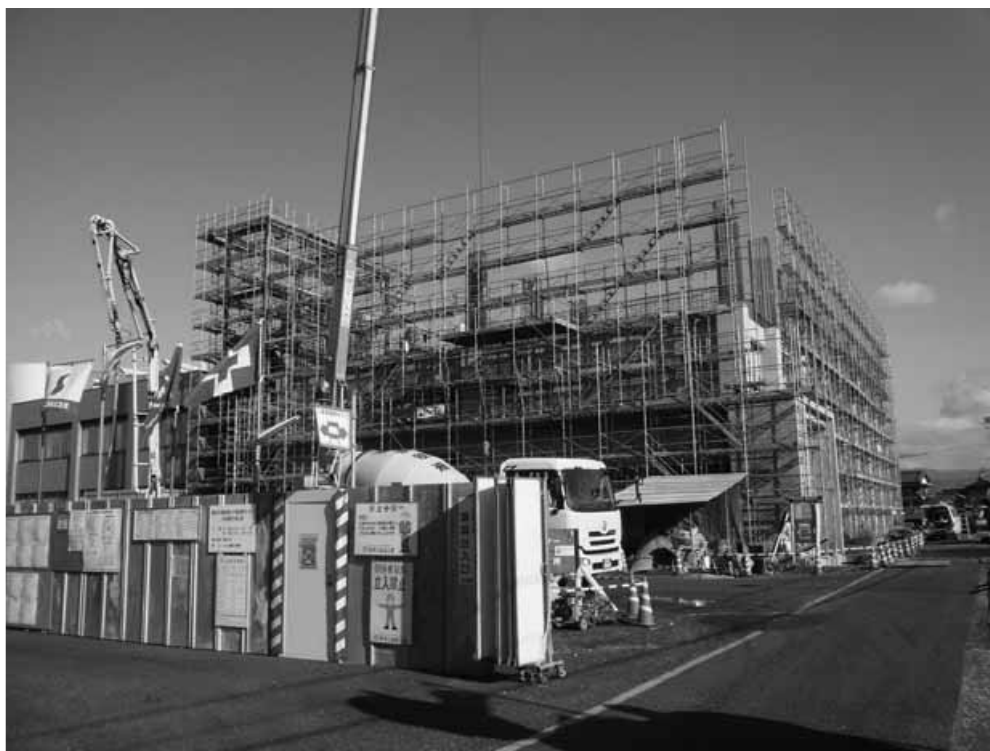
平成24年度補正事業 新保管庫棟建設 (平成26年3月27日撮影)
