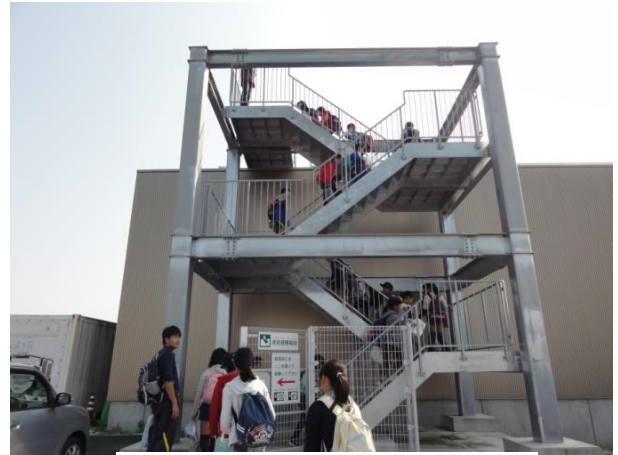
外階段から屋上へ
